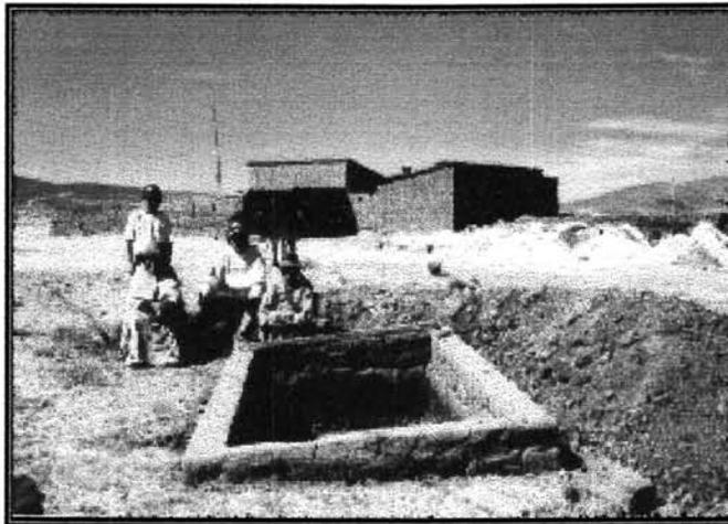
Una vez finalizada la excavación se procede a nivelar el fondo. Luego se introduce la grava que también se debe nivelar. El propósito de la grava es drenar los excesos de riego, evitando anegamiento de la zona radicular y la muerte por asfixia.
