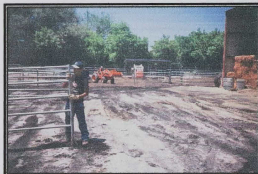
Instalación de Corrales.
