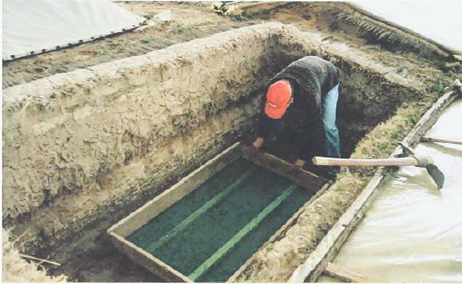
Instalación de la almaciguera
