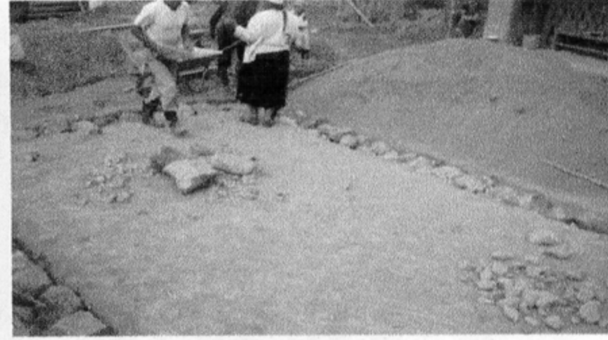
4. Inicio construcción cuyera
