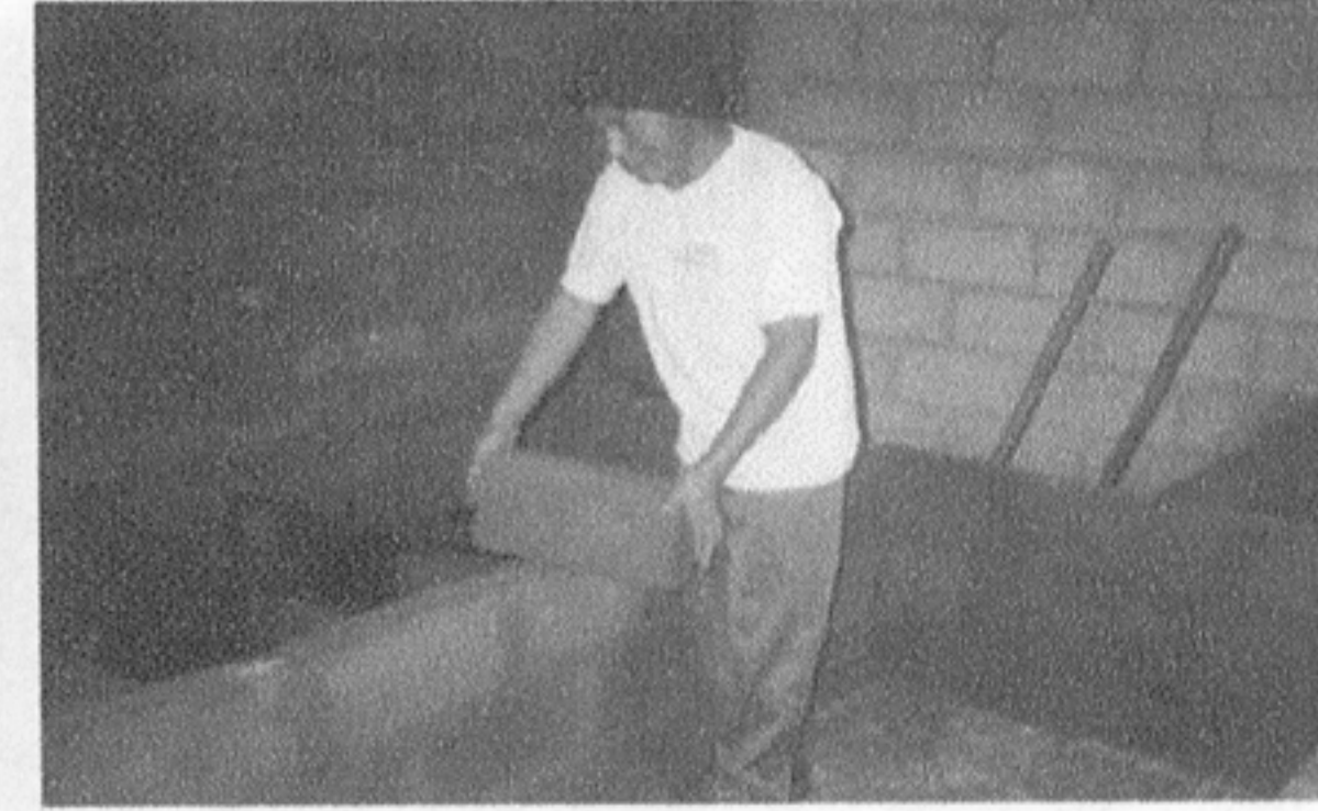
6. Construcción de pozas
